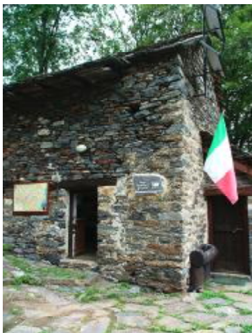
Il rifugio di Corte Buè prima della ristrutturazione
