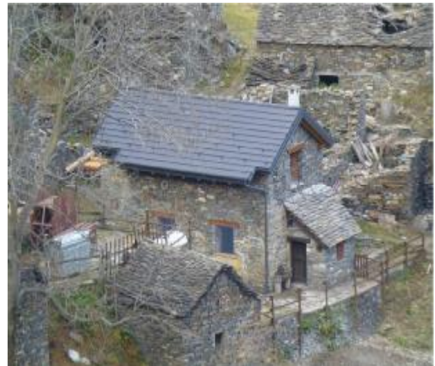
Il rifugio di Corte Buè appena ristrutturato
